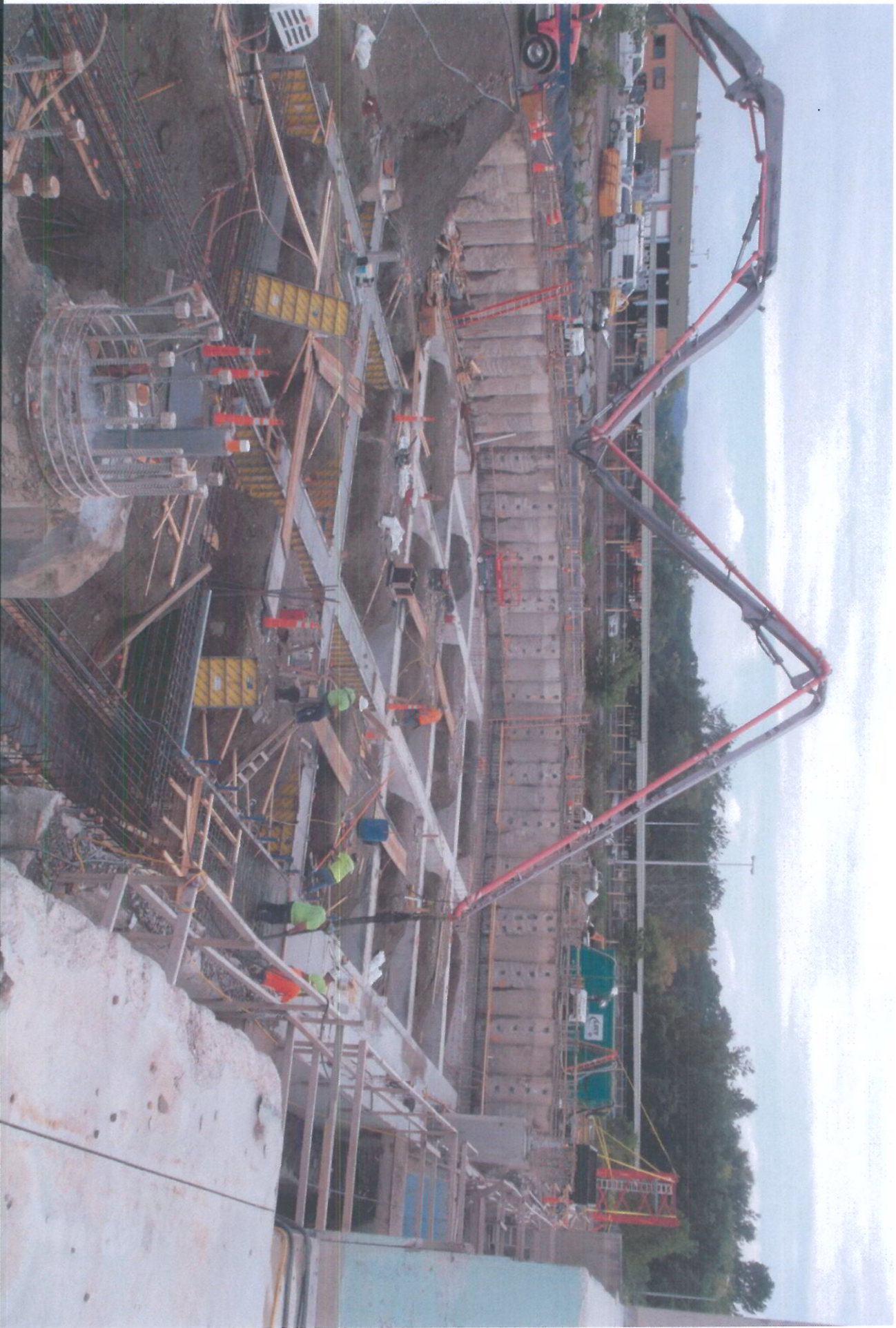
Con #9, Concrete Pour Four 9/9/16
